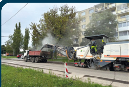
Rekonštrukcia cestnej komunikácie na Okružnej ulici
